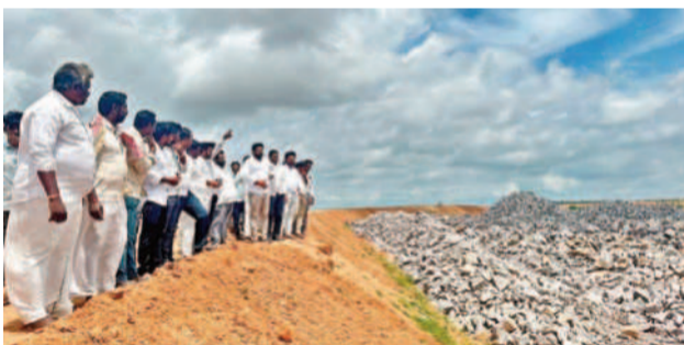
గట్టు ఎత్తిపోతల పనులను పరిశీలిస్తున్న గొంగూర్ రంజితకుమార్
