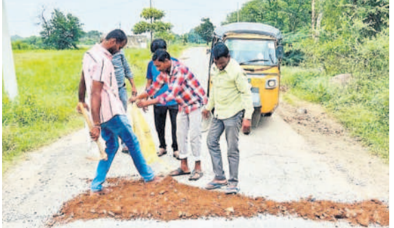
గొడవెల్లి గ్రామ సమీపంలోని రోడ్డుపై ఏర్పడిన గుంతలలో మట్టి పోసి చదును చేస్తున్న ఆటో డ్రైవర్లు
