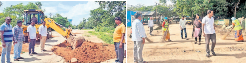
పరిగి: రోడ్డు మరమ్మత్తు చేయిస్తున్న మున్సిపల్ చైర్మన్ అశోక్ వికారాబాద్: పనులను పరిశీలిస్తున్న మున్సిపల్ చైర్మన్ రమణం
