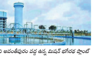
మిర్జాపూర్ గూడ డివిజన్ పరిధిలోని అవంతిపురం వద్ద ఉన్న మిషన్ భగీరథ ప్లాంట్
