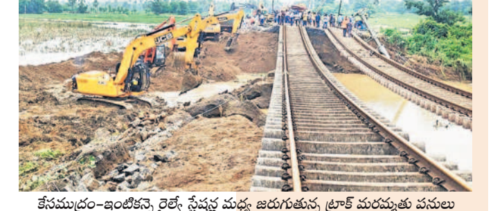
కేసముద్రం-ఇంటికిన్నీ రైల్వే స్టేషన్ మధ్య జరుగుతున్న ట్రాక్ మరమ్మత్తు పనులు
