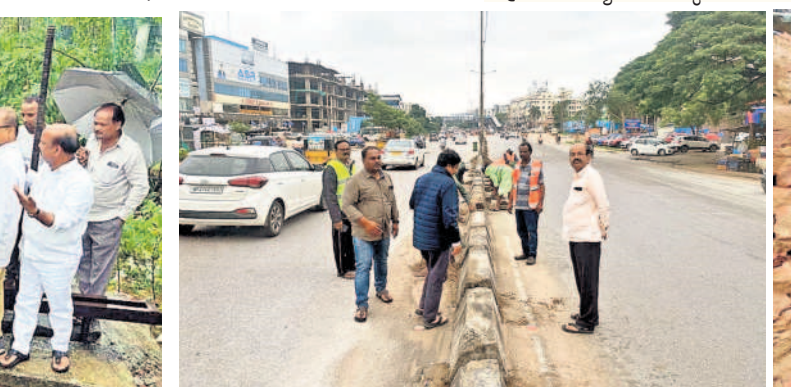
మట్టి తొలగింపు పనులను పరిశీలిస్తున్న చందాసగర్ డి.పి. మోహన్ రెడ్డి
