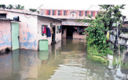
వరంగల్ మైసయ్యనగర్లో ఇంట్లోకి చేరిన నీరు
