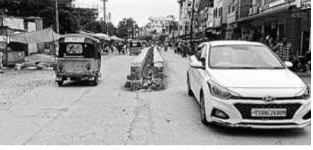
అసంపూర్ణగా వదిలిన డివైడర్ నిర్మాణం
