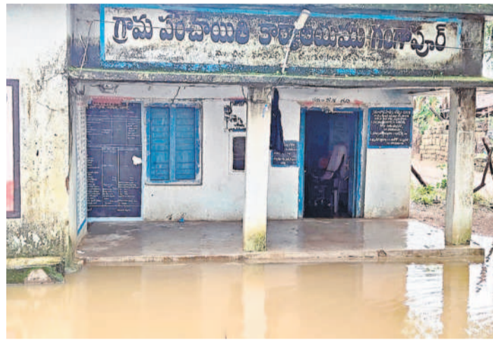
చింతమనపల్లి మండలం గంగాపూర్ గ్రామ పంచాయతీ ఎదుట నిలిచిన మురుగు నీరు
