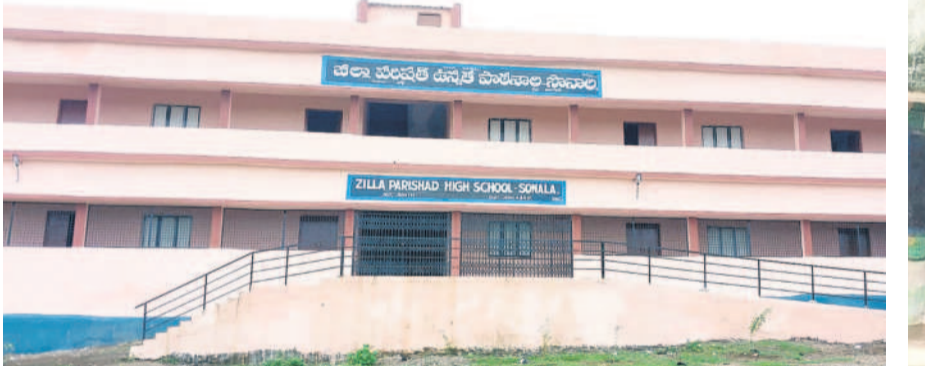
బోధ్ : సోనాల జడ్పీ పాఠశాలలో నిర్మాణం పూర్తయినా ప్రారంభించని భవనం
