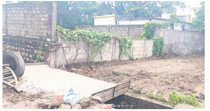
23 వార్డులో పూర్తయిన ర్యాంప్ నిర్మాణం
