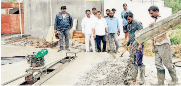
సీసీరోడ్డు పనులను పరిశీలిస్తున్న కార్పొరేటర్ బన్నాల
