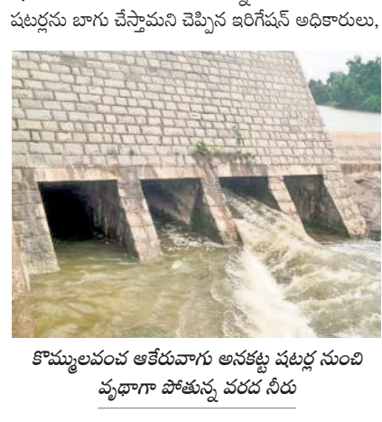
కొమ్మలపాడున ఆలేరునాగ అనకట్ల షట్టర్లను నిర్మిస్తూ పాతనూరు వరద నీరు
