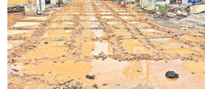
మాధవనగర్ కాలనీలో సూతనంగా నిర్మించిన సీసీ రోడ్డు
