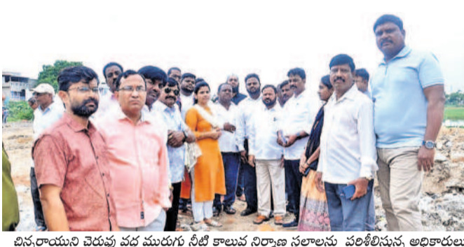
చిన్నరాయని చెరువు వద్ద మురుగు నీటి కాలువ నిర్మాణ స్థలాలను పరిశీలిస్తున్న అధికారులు
