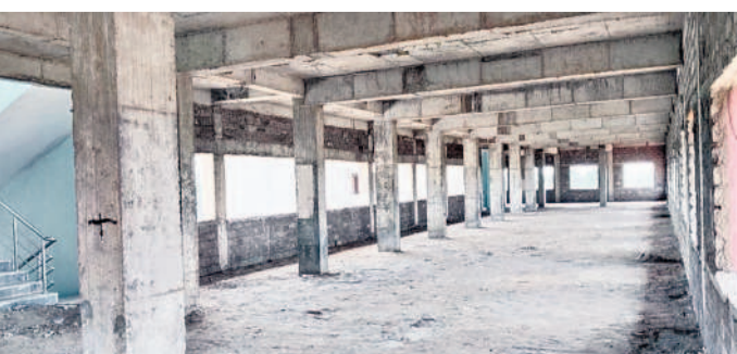
రెండో ఫ్లోర్లో అసంపూర్ణంగా ఉన్న నిర్మాణ పనులు
