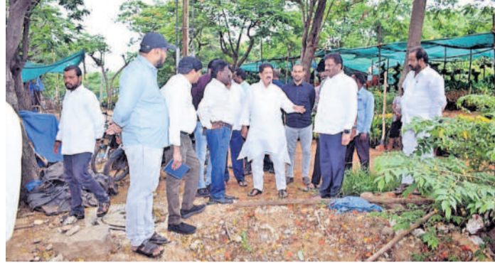
కేపీహెచ్ఐటీ కాలనీలో డ్రైనేజీ పనులపై పరిశీలిస్తున్న ఎమ్మెల్యే కృష్ణారావు, కార్పొరేటర్ శ్రీనివాసరావు, అధికారులు
