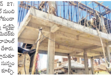
నిర్మాణ పనులు ప్రారంభించారు
