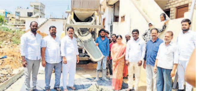
నర్సాపూర్, జూన్ 16: మున్సిపాలిటీలోని సీసీ రోడ్డు నిర్మాణ పనులు పరిశీలించారు. పనుల్లో లోపం ఉందా చూసుకోవాలని
