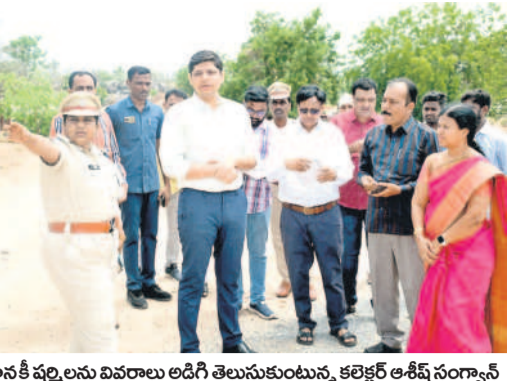
ఎస్సీ జానకి పద్మిని సహా జిల్లా పోలీసు కార్యాలయ నిర్మాణ పనుల పరిశీలన
