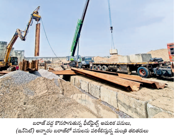
బాజీ వద్ద కొనసాగుతున్న పీటీసీల అవకాశ పనులు, (ఇన్సెట్) అన్నారం బాజీలో పనులను పరిశీలిస్తున్న మంత్రి తదితరులు
