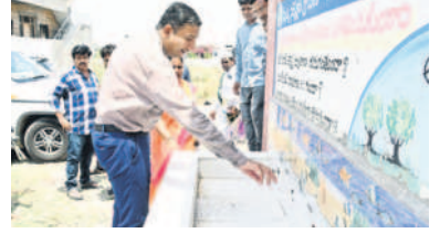
నిర్మాణ పనులు పరిశీలించిన కలెక్టర్ రాజ్ కుమార్ షా
