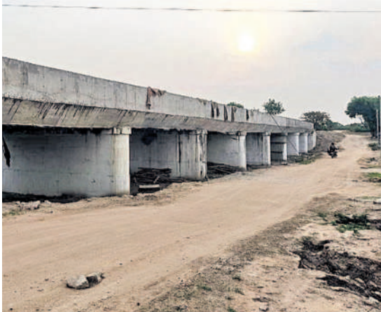
పూర్వకాని ఎంబీడబ్ల్యు బ్రిడ్జి నిర్మాణం పనులు
