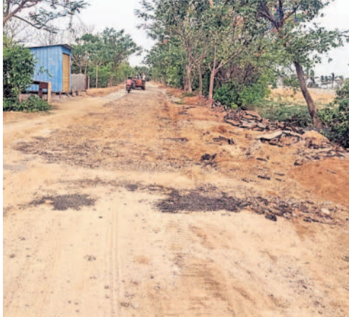
శంకరాపూర్ వద్ద కొనసాగుతున్న రోడ్డు పనులు
