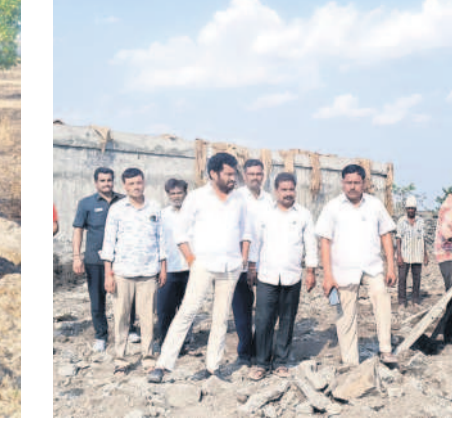
బజార్ హత్తుర్ కోల్లూర్ సమీపంలోని వంతెన నిర్మాణ పనులను పరిశీలిస్తూ..
