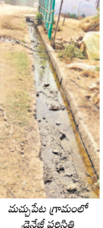
ముచ్చపేట గ్రామంలో డ్రైనేజీ పరిశీలి
