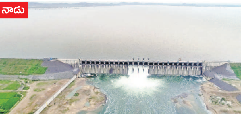
● ఇది కేసీఆర్ పనితనం మిడ్మానేరు జలాశయం గట్ట నుంచి దుంకుతున్న కాశ్శర్ల జలాలు (ఫైల్)
