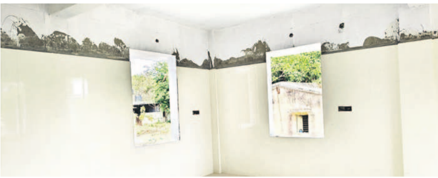
ప్రజా ఆరోగ్య కేంద్రం భవన నిర్మాణంలో కొనసాగుతున్న బ్రిక్ వేసే పనులు
