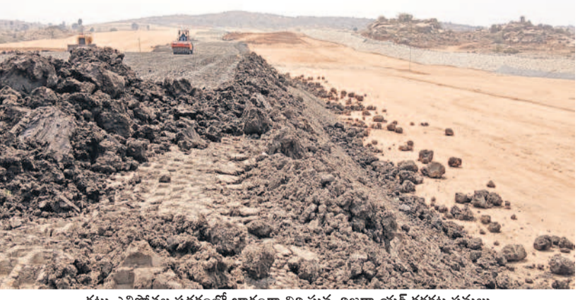
గట్టు ఎత్తిపోతల పథకంలో భాగంగా నిర్మిస్తున్న రిజర్వాయర్ కరకట్ట పనులు
