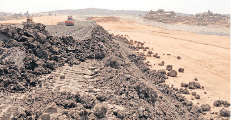
గట్టు ఎత్తిపోతల పథకంలో భాగంగా నిర్మిస్తున్న రిజర్వాయర్ కరకట్ట పనులు
