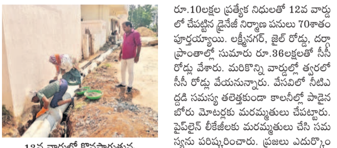
12వ వార్డులో కొనసాగుతున్న అండర్ డ్రైనేజీ నిర్మాణ పనులు
