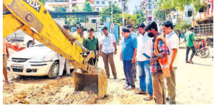
మట్టి తొలగింపు పనులను పరిశీలిస్తున్న కార్పొరేటర్ పవన్ కుమార్
