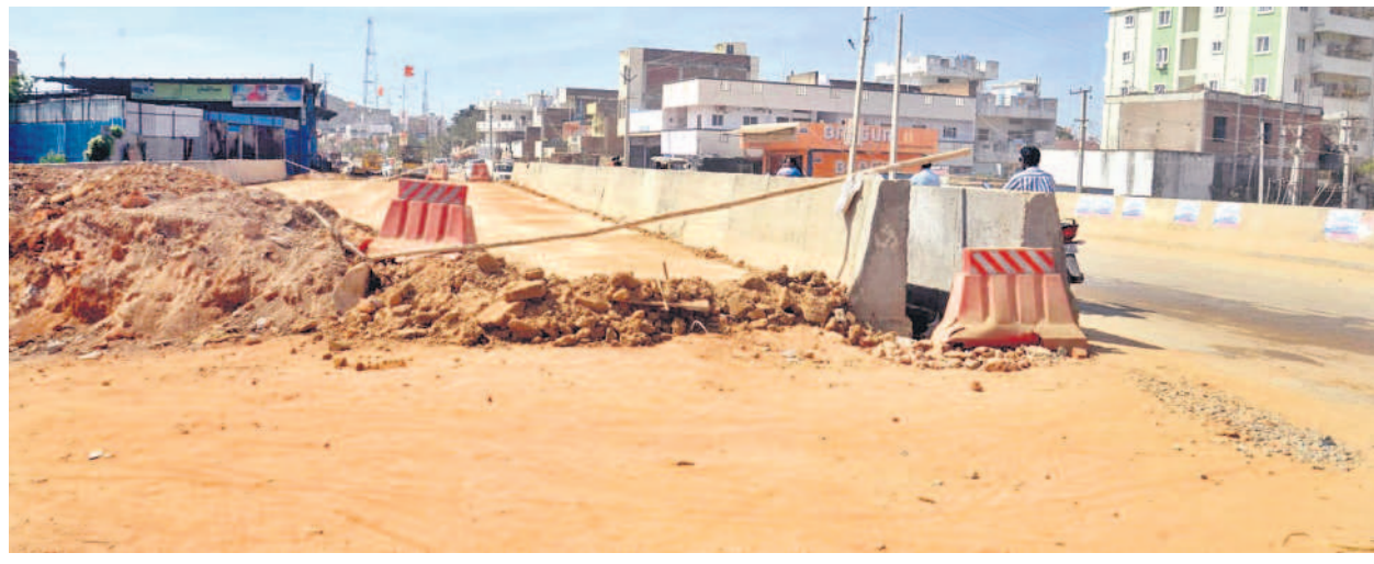
వనపర్తి పట్టణంలో అసంపూర్ణగా ట్రిప్లి నిర్మాణ పనులు
