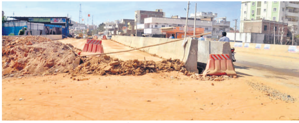
వనపర్తి పట్టణంలో అసంపూర్ణగా ట్రిప్లి నిర్మాణ పనులు
