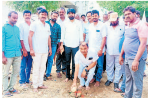
అలింగాపురంలో సీసీ రోడ్డు పనులను ప్రారంభిస్తున్న ఎంపీపీ గోపాల్
