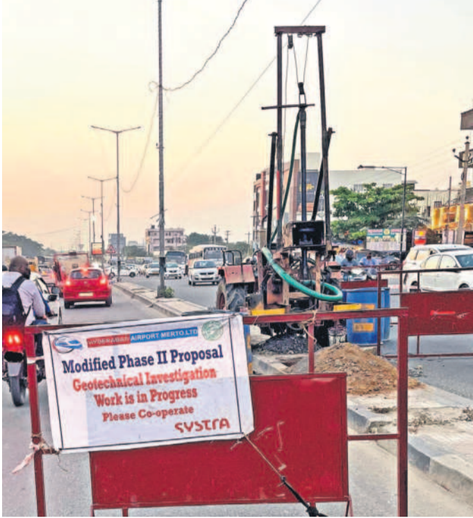
మియాపూర్-చటాన్ చెరూ మార్గంలో కొనసాగుతున్న మెట్రో పనులు
