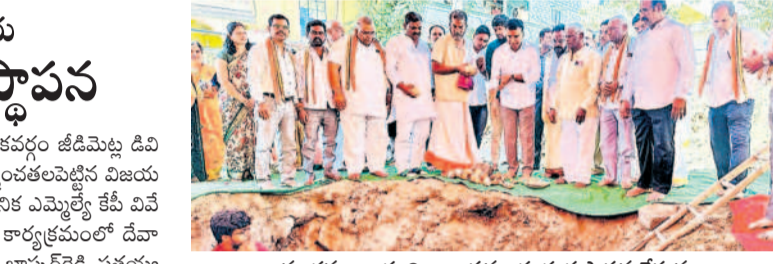
నూతన ఆలయ నిర్మాణ పనులకు శంకుస్థాపన చేస్తున్న ఎమ్మెల్యే కేపీ వివేకానంద్, ఆలయ ఉన్న భాగం
