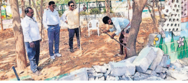
నేతాజీ పార్కు ప్రసార నిర్మాణ పనులను ప్రారంభిస్తున్న 9వ వార్డు కౌన్సిలర్ శ్రీకాంత్ స్వామి
