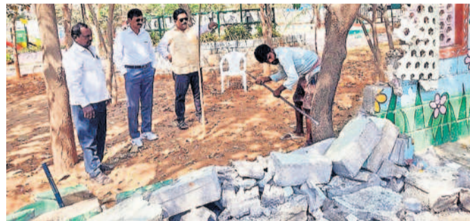
నేతాజీ పార్కు ప్రహారీ నిర్మాణ పనులను ప్రారంభిస్తున్న 9వ వార్డు కౌన్సిలర్ శ్రీకాంత్ సామి
