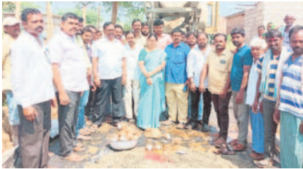
అర్బన్, ఫిబ్రవరి 20 : సీసీ రోడ్డు పనులకు శంకుస్థాపన చేస్తున్న ఎంపీపీ రేణుక లక్ష్మీనారాయణ్
