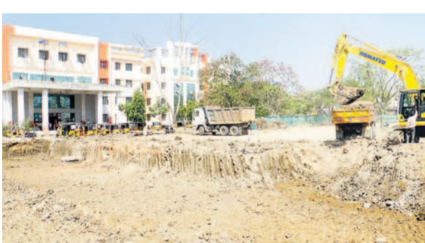
లిమ్స్ లో కొనసాగుతున్న క్రిటికల్ కేర్ యూనిట్ భవన నిర్మాణ పనులు
