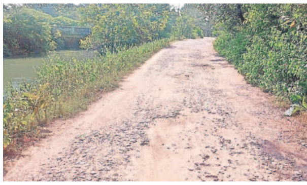
కడం మండలంలోని పాండవపూర్ నుంచి డ్యాంగూడ వరకు నిలిచిన రోడ్డు పనులు
