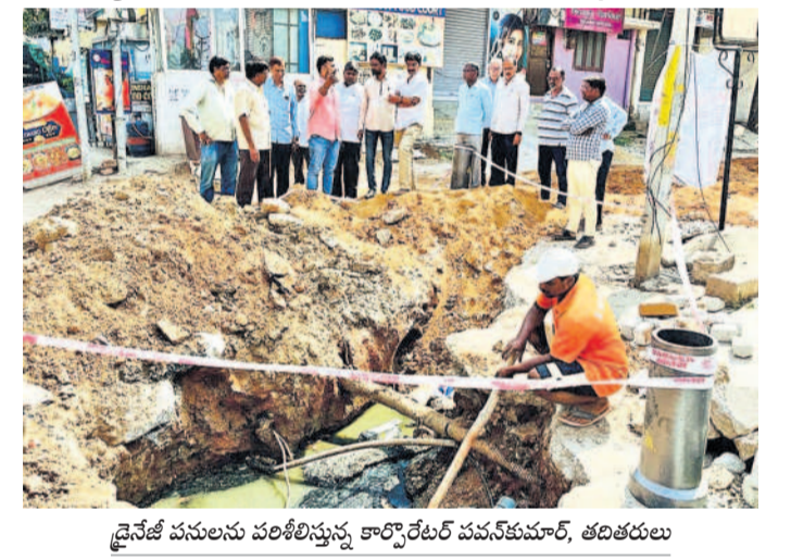
డ్రైనేజీ పనులను పరిశీలిస్తున్న కార్పొరేటర్ పవన్ కుమార్, తదితరులు
