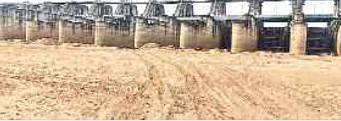
పనులు చేపట్టకపోవడంతో నిర్మాణపనులు ఉన్న మేడిగడ్డ బలాజీ ప్రాంతం
