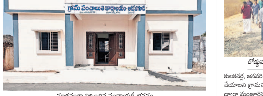
నూతనంగా నిర్మించిన పంచాయతీ భవనం
