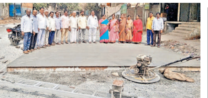
అరుణ్కోటి కాల్నీలో రోడ్డు నిర్మాణ పనులను పరిశీలించిన కార్పొరేటర్ మేమలత
