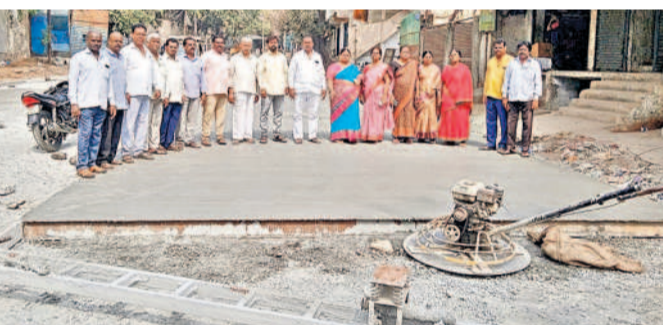
అరుణకోటి కానీల్ రోడ్డు నిర్మాణ పనులను పరిశీలించిన కార్పొరేటర్ మేమలత
