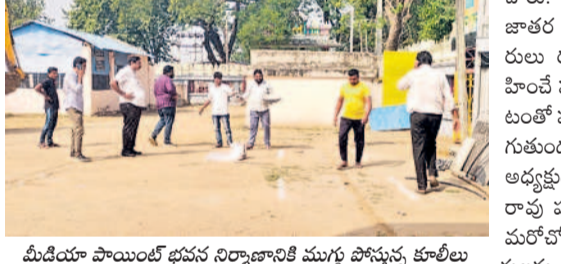
మీడియా పాయింట్ భవన నిర్మాణానికి ముగ్గు పోస్టును కూలిపెట్టారు
