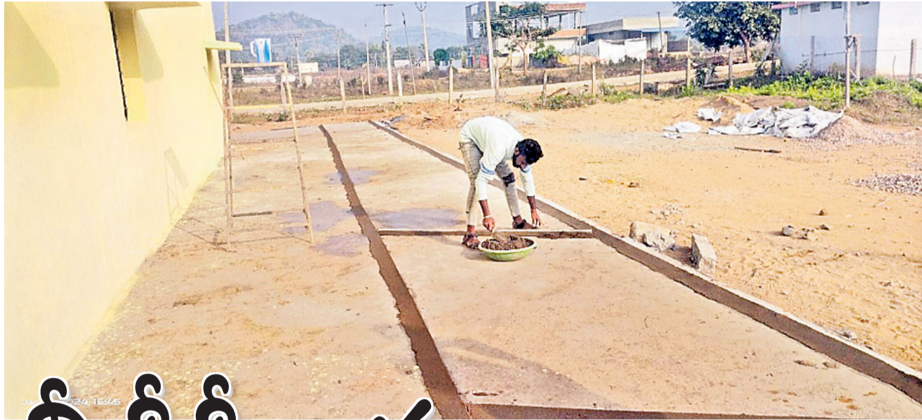
మేడారం పంచాయతీ పరిధిలో ఉన్న శానిటేషన్ భవనం వద్ద సీసీ పనులు
