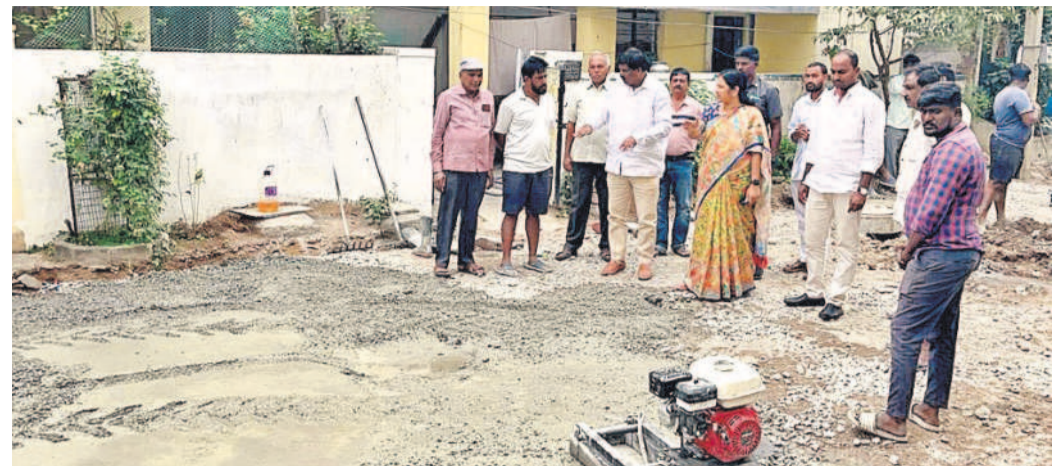
సీసీ రోడ్డు పనులను పరిశీలిస్తున్న డిప్యూటీ మేయర్ మోతే శ్రీలతా శోభన్ రెడ్డి
