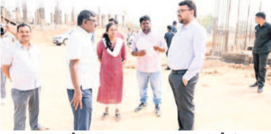
మంచెలపై అధిష్టన కలెక్టర్ రామారావు, జనవరి 9: ప్రభుత్వ దవాఖాన నిర్మాణ పనులను పరిశీలన.
